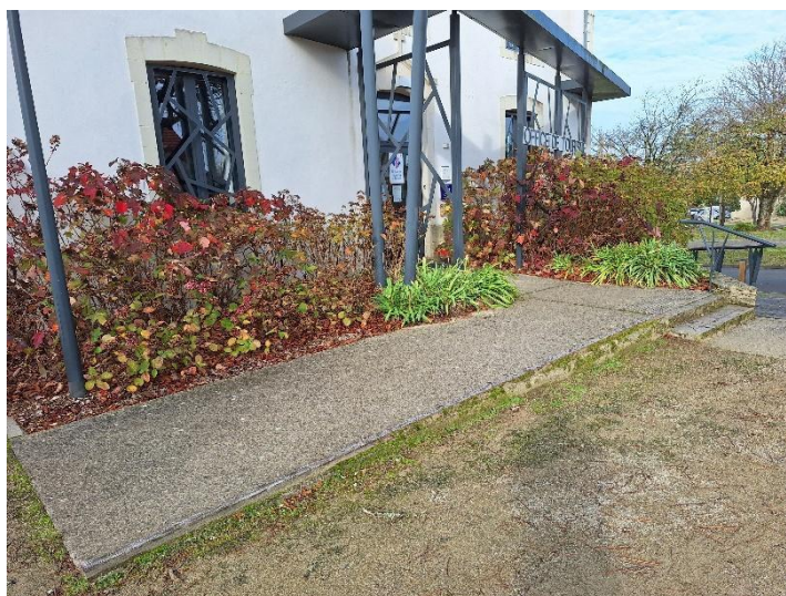
Photo 6 : passerelle vers la porte d'entrée
