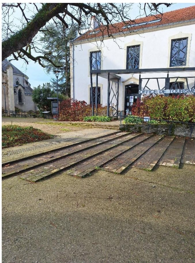
Photo 4 : espace devant l'entrée avec des marches basses
