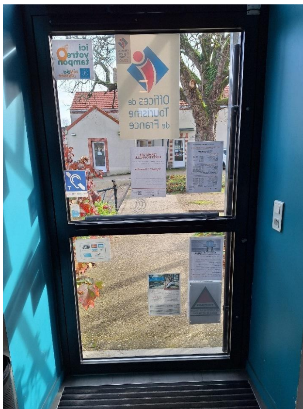
Photo 8 : porte d'entrée vue de l'intérieur.
