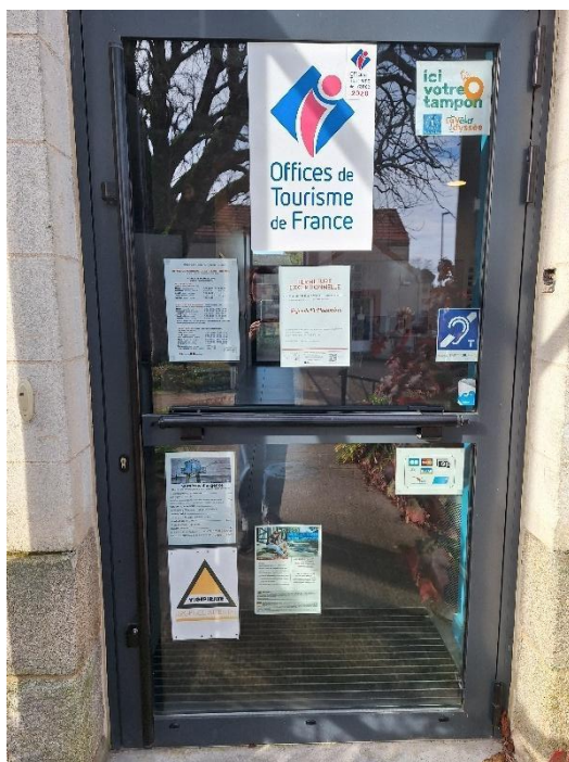
Photo 7 : porte d'entrée vue de l'extérieur.
