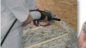
La déperdition de chaleur par la toiture est de 30 %. Isoler les combles permet ainsi de réaliser des économies d'énergie.
