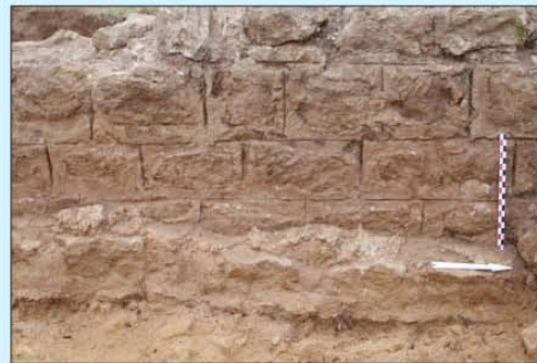
Détail de l'élévation du mur de soutènement avec joints tirés au fer pour donner l'illusion d'un parement régulier
